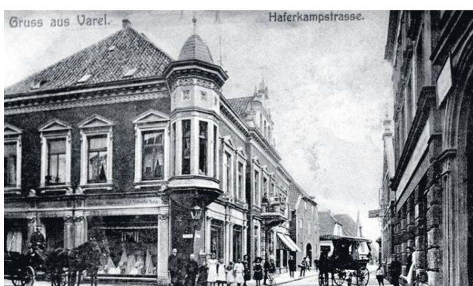
Das Geschäftshaus Schwabe in der Haferkampstraße wurde 1974 abgerissen.
