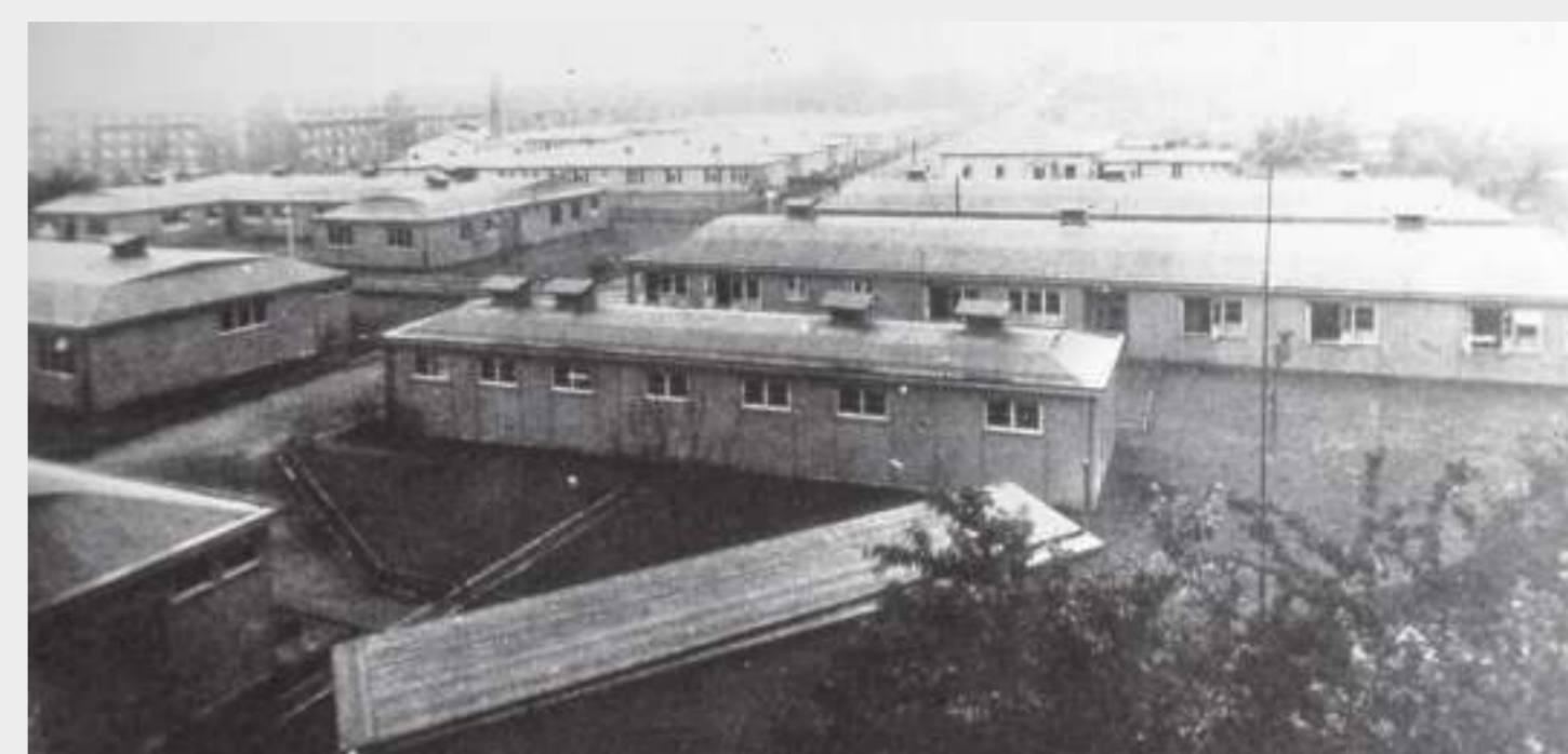
Arbeiterlager Norderneystraße der Hafenneubaudirektion, ca. 1936
