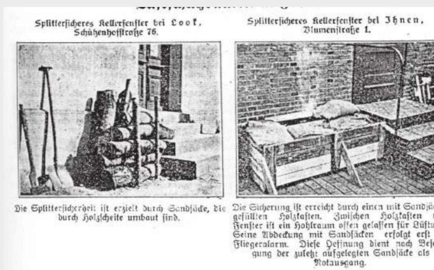
Aangeblich „splittersichere“ Kellerfenster in Jever als Muster zum Nachbauen, unmittelbar vor Beginn des Krieges (Jev. Wochenblatt, 26. August 1939)
